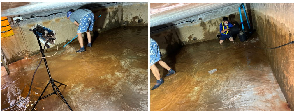
ภาพที่ 2-36 ล้างทำความสะอาดถึงสำรองน้ำใช้
