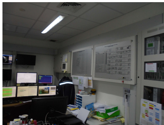
ภาพที่ 2-30 แผงควบคุมสัญญาณเตือนอัคคีภัยและโทรทัศน์วงจรปิด
