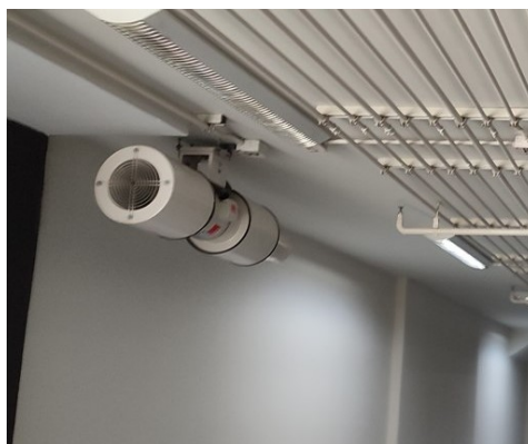
ภาพที่ 2-6 พัดลมระบายอากาศที่มีตัวกรองอากาศ
