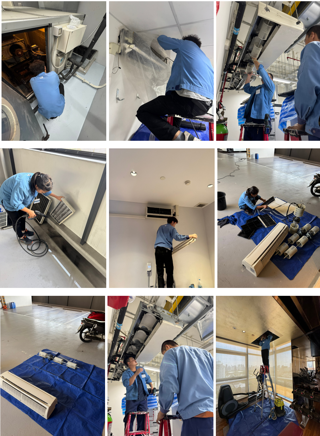
ภาพที่ 2-42 ล้างทำความสะอาดเครื่องปรับอากาศ
