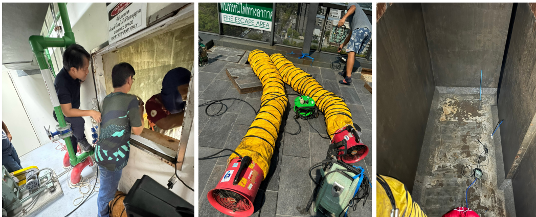
ภาพที่ 2-36 ล้างทำความสะอาดดังสำรวจน้ำใช้ (ต่อ)
