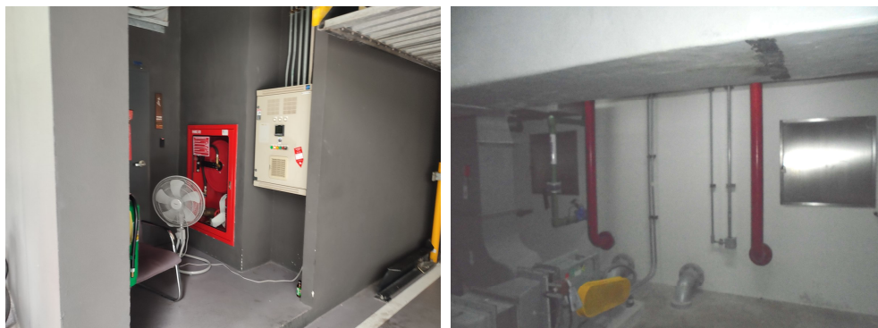
ภาพที่ 2-21 ตู้เก็บสายฉนวนดับเพลิงพร้อมอุปกรณ์ และท่ออื่น
